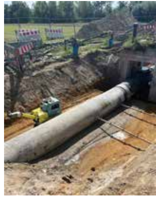
Neu eingezogene Kanalleitung in altes Schachtbauwerk
