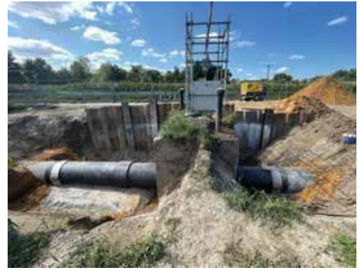
In Betrieb genommener Kanal
